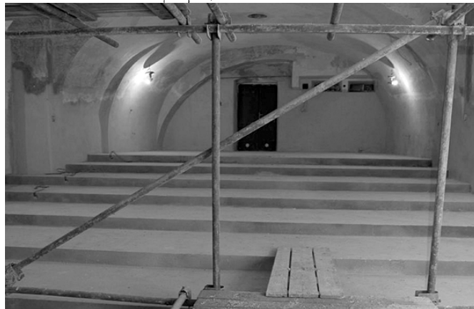
Záběry z průběhu rekonstrukce. Foto: Jan Smolka.
