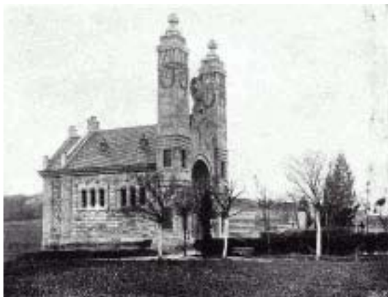
OBR.7. Kostnice (ossarium) na vojenském hřbitově u Kbelnice, architekt Václav Weinzettel, 1906.
